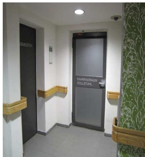
Рисунок 208. Опорные поручни на путях движения. Варианты решения
