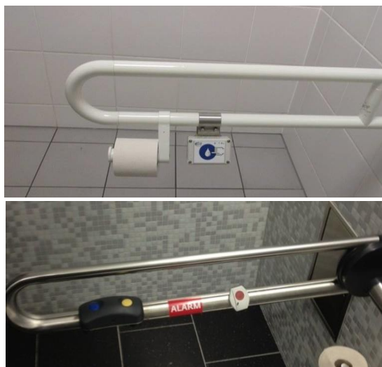
Рисунок 150. Варианты устройства кнопки слива на поручнях
