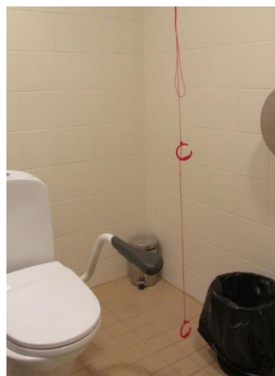
Рисунок 183. Схемы размещения устройства вызова в доступной душевой
