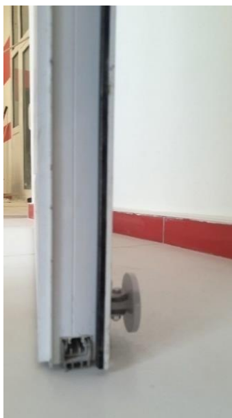
Рисунок 104. Вариант решения беспорогового входа с терморасширяющейся прокладкой
