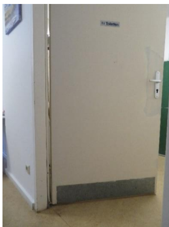
Рисунок 178. Противоударная полоса в нижней части двери
