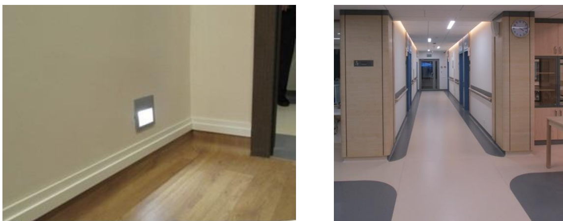
Рисунок 97. Вариант устройства противоударной панели в нижней части стен доступных путей движения
