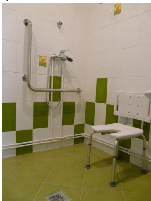
Рисунок 132. Вариант решения доступной душевой кабины с переносным сиденьем
