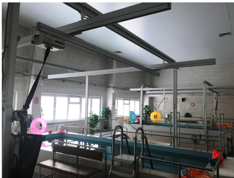
Рисунок 127. Потолочный подъемник для инвалидов
