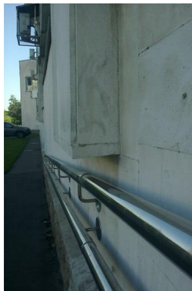
Рисунок 207. НЕПРАВИЛЬНО! Недопустимые препятствия над поручнями
