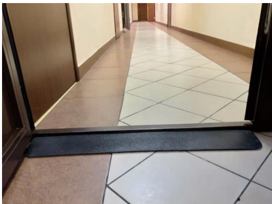
Рисунок 80. Примеры порогов, сглаженных приставными пандусами
