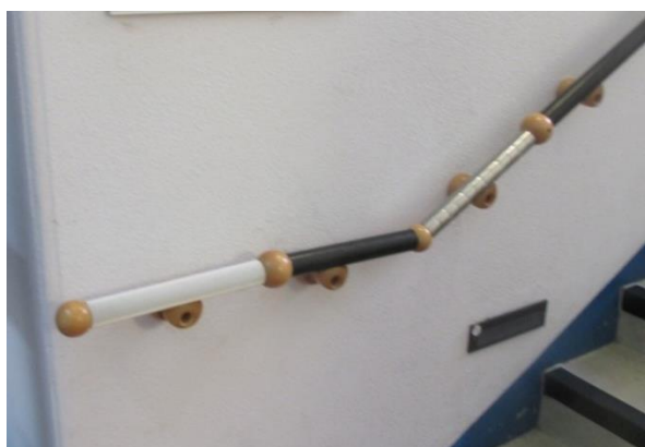
Рисунок 231. Варианты тактильной маркировки окончания перил
