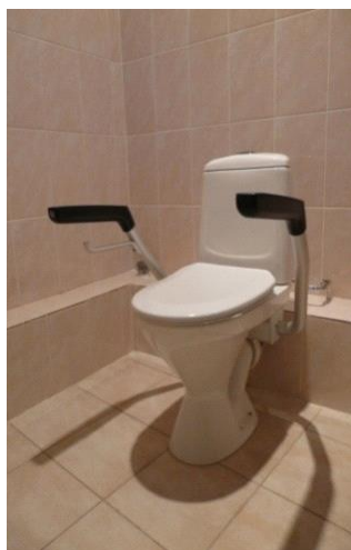
Рисунок 160. Поручни с креплением к унитазу
