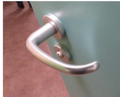
Рисунок 98. Нажимные ручки удобной конструкции для инвалидов
