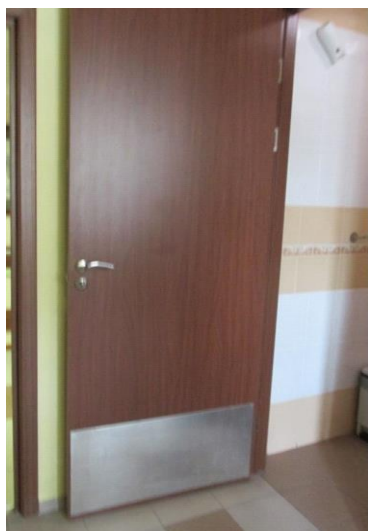
Рисунок 102. Противоударная панель в нижней части дверного полотна
