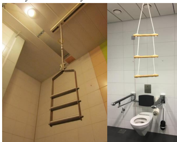
Рисунок 165. НЕ ПРИМЕНЯТЬ! Варианты исполнения штанги с подвесными ручьями – легкая деревянная лестница для пересадки
