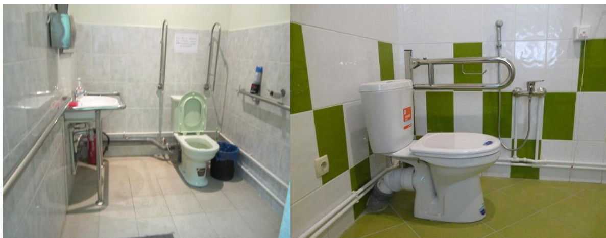
Рисунок 161. НЕПРАВИЛЬНО! Откидной поручень вдоль стены не устанавливать!
