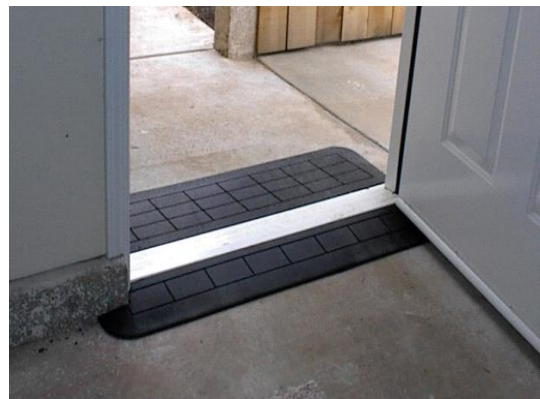
Рисунок 80. Примеры порогов, сглаженных приставными пандусами
