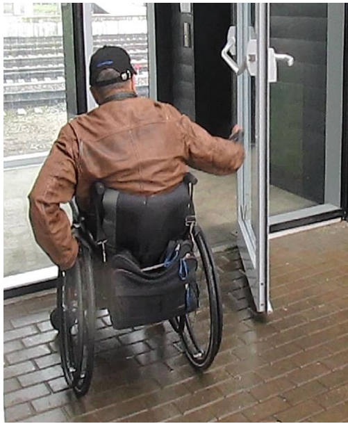
Рисунок 77. НЕПРАВИЛЬНО! Не обеспечена задержка закрывания двери 5 с и инвалиду во время движения несколько раз приходится отталкивать дверь
