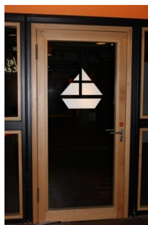
Рисунок 101. Варианты решения маркировки стеклянных поверхностей дверей
