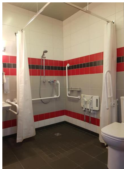
Рисунок 134. НЕПРАВИЛЬНО! Ошибки при размещении откидных сидений в доступной душевой относительно смесителей и душа
