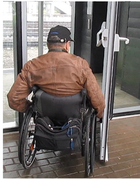
Рисунок 77. НЕПРАВИЛЬНО! Не обеспечена задержка закрывания двери 5 с и инвалиду во время движения несколько раз приходится отталкивать дверь
