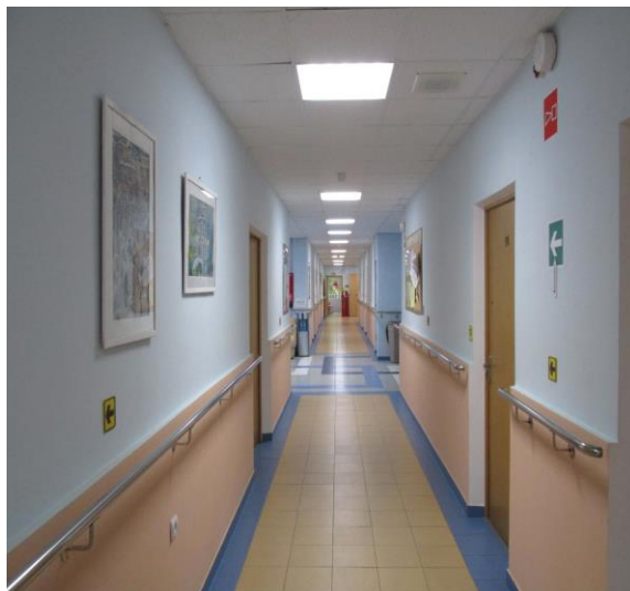
Рисунок 107. Вариант решения коридора шириной менее 4 м без ТНУ, где ориентиром служит контрастный плинтус и цвет напольного покрытия в холлах, двери в контрастном исполнении, поручни
