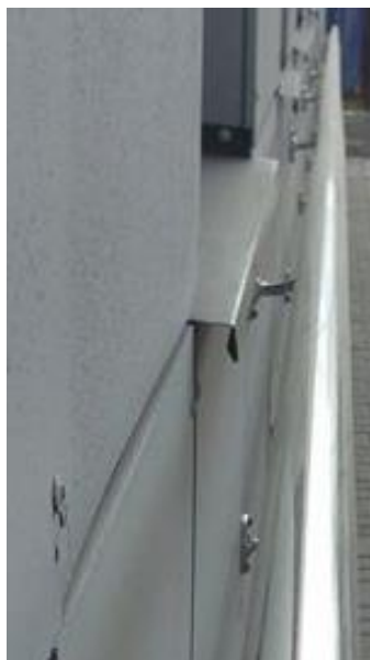
Рисунок 207. НЕПРАВИЛЬНО! Недопустимые препятствия над поручнями
