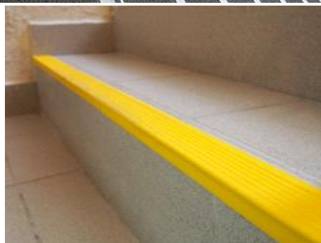
Рисунок 54. Примеры маркировки ступеней контрастным цветом и фотолюминисцентными накладками
