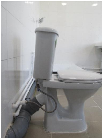
Рисунок 146. НЕПРАВИЛЬНО! Сливной бачок унитаза для инвалидов должен быть надежно закреплен.
