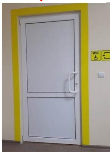
Рисунок 100. Пример неэффективной маркировки дверного проема
