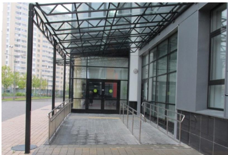
Рисунок 61. Широкий пандус на общих путях движения дополняет пандус для инвалидов
