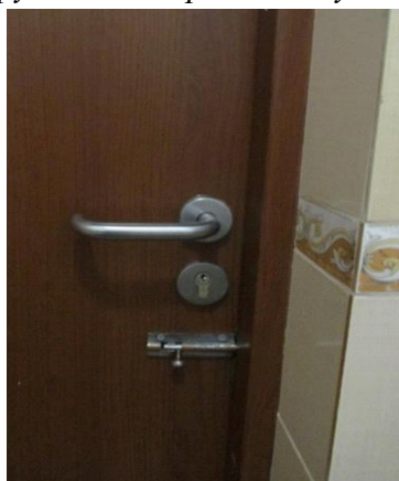
Рисунок 180. НЕПРАВИЛЬНО! Недопустимый вариант закрытия двери с помощью щеколд.
