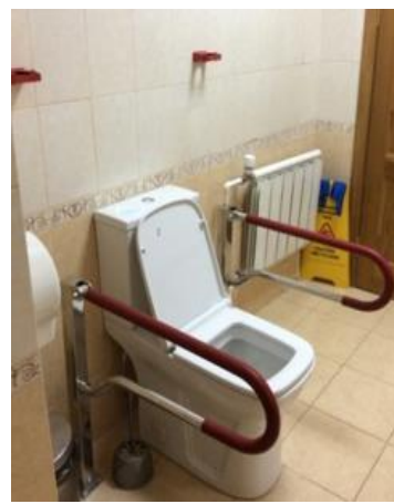
Фиксация поручня с помощью Toolflex, расположенного на стене
