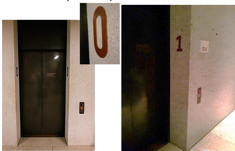
Рисунок 214. Примеры обозначения номера этажа на боковых поверхностях дверных проемов лифтовой шахты
