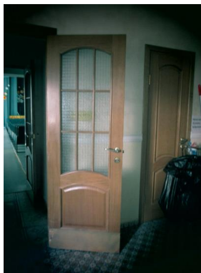
Рисунок 102. Противоударная панель в нижней части дверного полотна
