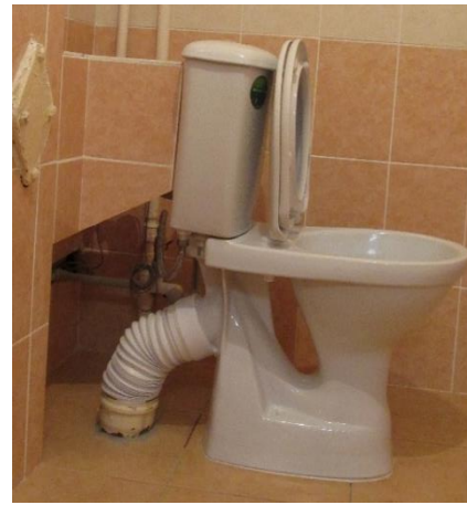
Рисунок 146. НЕПРАВИЛЬНО! Сливной бачок унитаза для инвалидов должен быть надежно закреплен.
