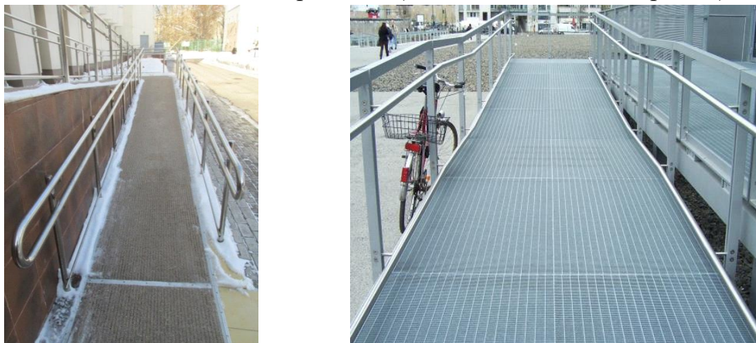
Рисунок 71. Примеры материалов, обеспечивающих нескользкую поверхность пандуса.
