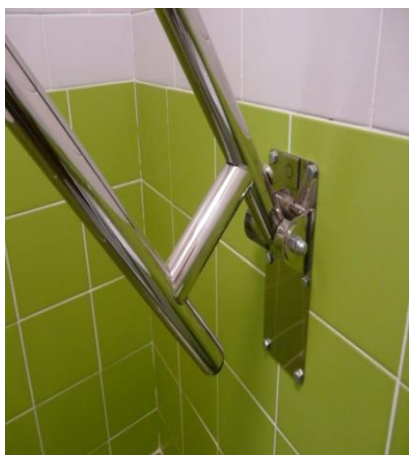
Фиксация поручня магнитом
