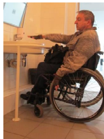
Короб обшивки коммуникаций под раковиной мешает доступу к крану
