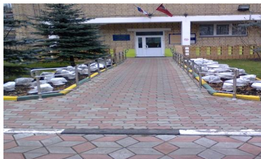
Рисунок 30. НЕПРАВИЛЬНО! В проектом решении было предложено устройство сопряжения путем укладки бордюрного камня плашмя, что недопустимо
