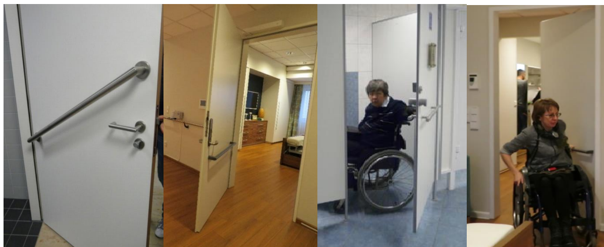
Рисунок 177. Варианты установки поручня на внутренней стороне двери
