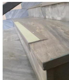
Рисунок 54. Примеры маркировки ступеней контрастным цветом и фотолюминисцентными накладками
