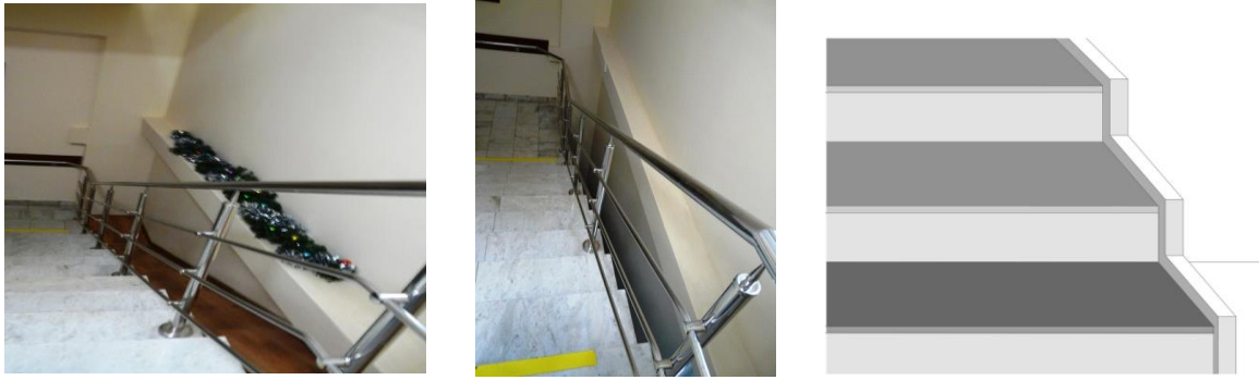
Рисунок 113. Варианты ограждения лестниц, предотвращающие соскальзывание трости или ноги
