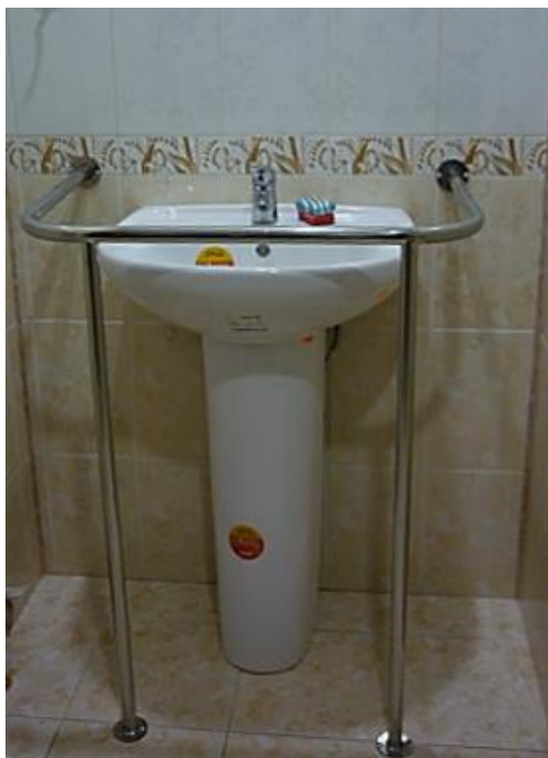
Рисунок 168. НЕПРАВИЛЬНО! Конструкция раковины и опорного поручня затрудняет доступ для инвалида на кресле-коляске. Данное решение недопустимо
