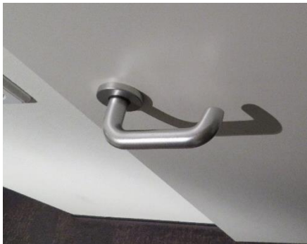
Рисунок 98. Нажимные ручки удобной конструкции для инвалидов
