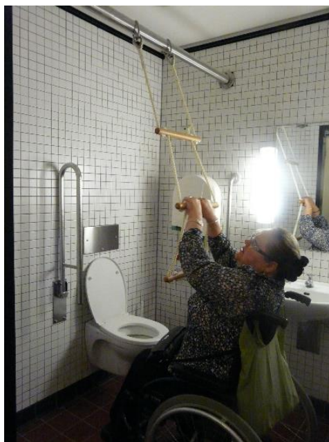
Рисунок 166. НЕ ПРИМЕНЯТЬ! Пересадка с помощью штанги с подвесными ручьятками – легкая деревянная лестница для пересадки. Не каждый инвалид сможет использовать данное устройство
