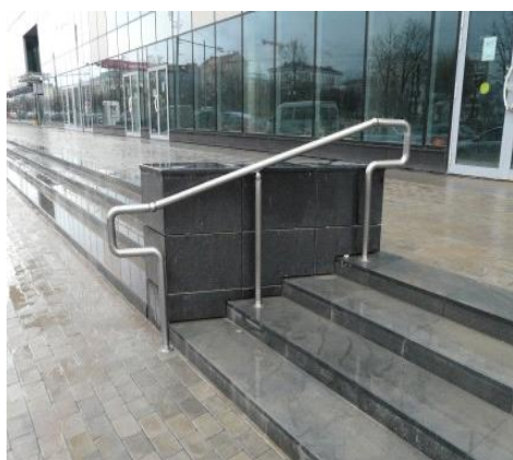
Рисунок 201. Варианты решения поручней на лестнице с горизонтальными завершениями
