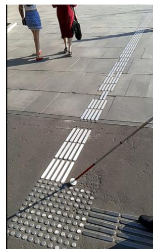
Рисунок 26. Обозначение направления движения с помощью тактильной полосы по ГОСТ Р 52875-2018
