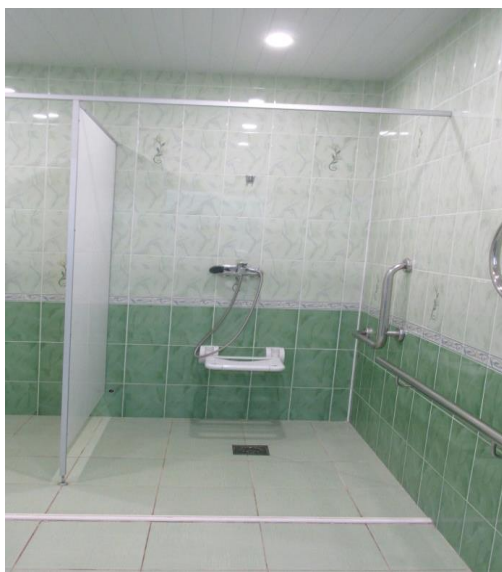
Рисунок 134. НЕПРАВИЛЬНО! Ошибки при размещении откидных сидений в доступной душевой относительно смесителей и душа
