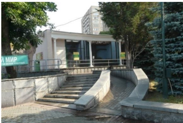
Повышенный уклон более 1:6 и отсутствие поручней. Частичная доступность.
