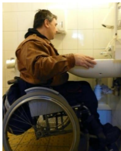
Короб под раковиной затрудняет пользование водопроводным краном
