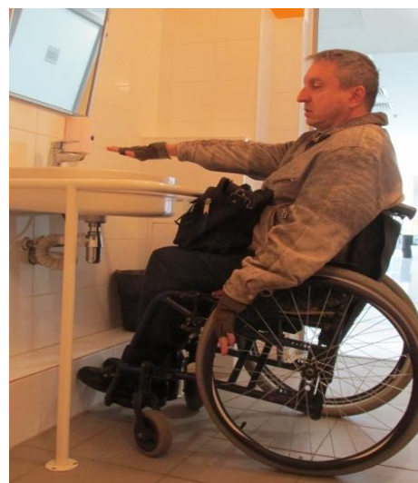
Короб под раковиной затрудняет пользование водопроводным краном
