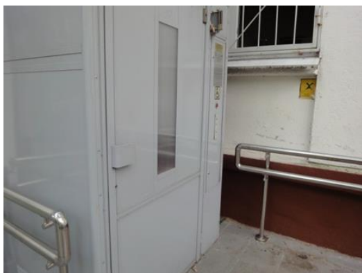
Платформа в огражденной шахте
