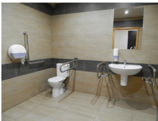
Поручни в доступной кабине санузла. Недостатки: раздатчик бумаги вне зоны досягаемости, поручни у раковины расположены на большом расстоянии и неудобны, нижний край
