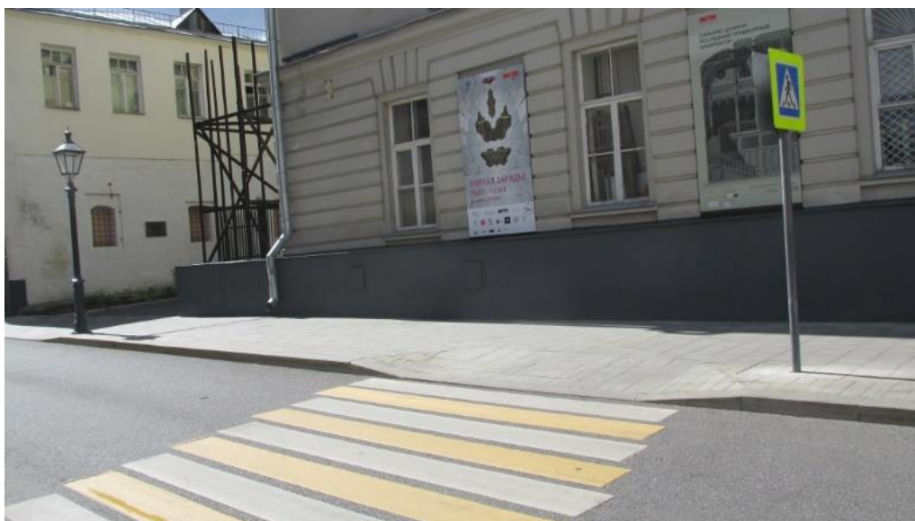
Съезд с ровной дорожкой вдоль фасада здания для безопасного прохода и разворота на съезд кресла-коляски
